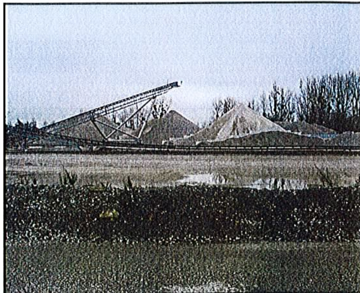
FIG. 2 – Vue vers l'EST, depuis le point d'implantation de la centrale.
